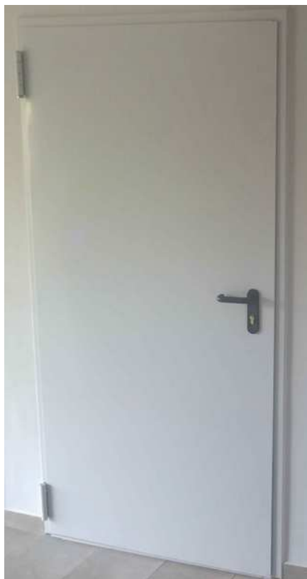
Rys. 3. Drzwi przeciwpożarowe płaszczowe, jednoskrzydłowe, pełne. Klasa EIS60 w kolorze RAL7035.
